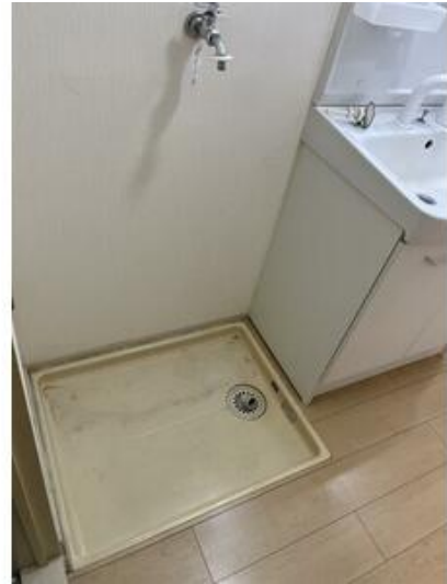
室内洗濯機置場
